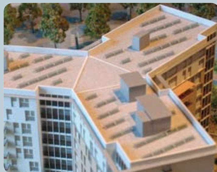
Les panneaux solaires et les chaufferies sont installés sur les toitures.
